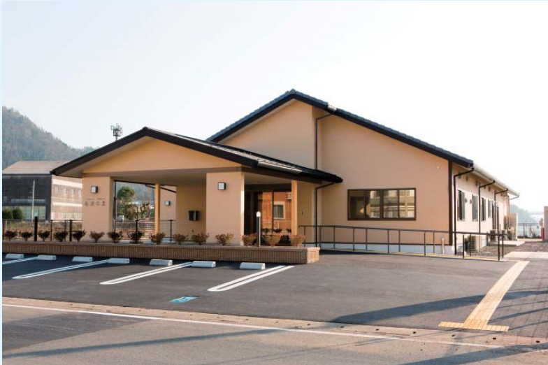
▲正面外観（玄関前に駐車場が配されているので、毎日の通所にも便利）
