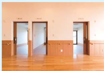
▲壁には持ちやすい手すりが設置されている
