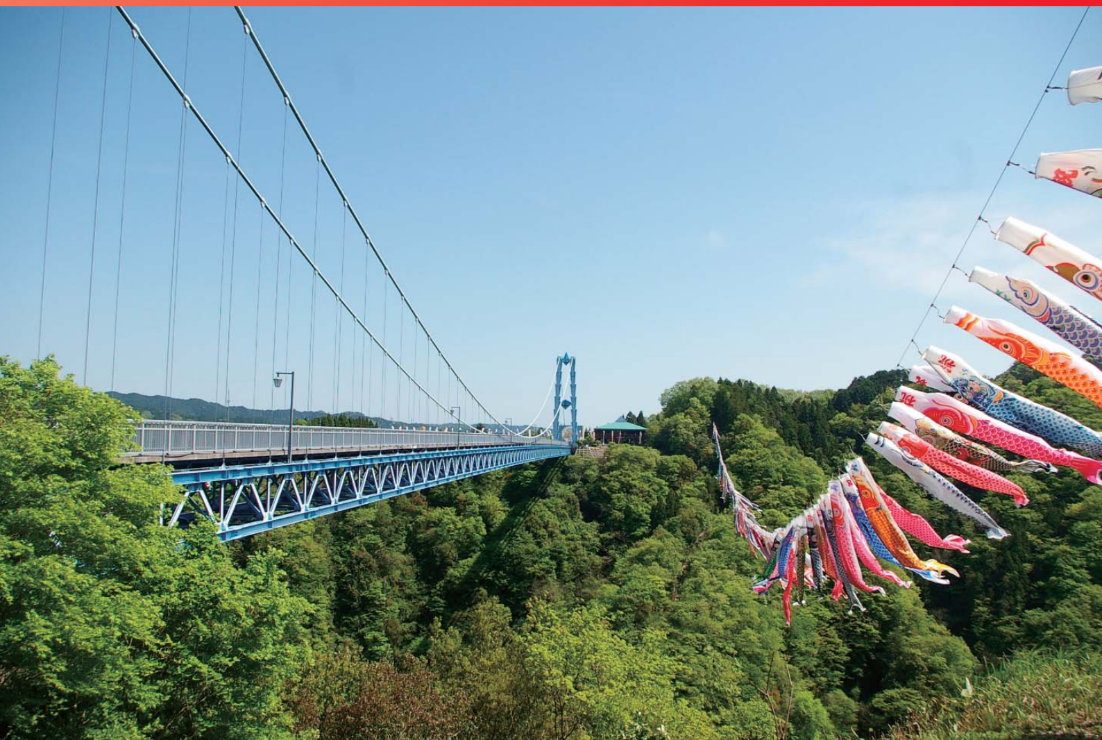
龍神大吊り橋(茨城県)
